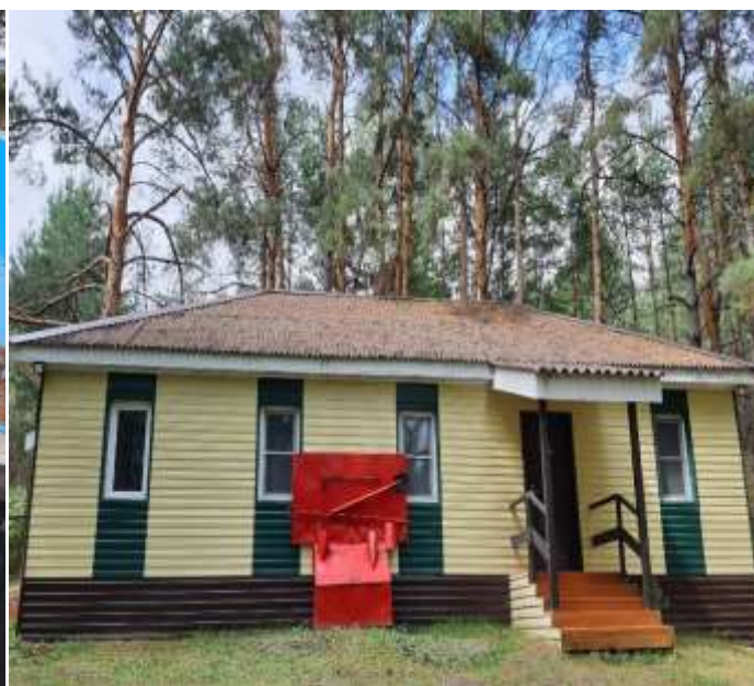
обшивка стен металло сайдингом с устройством металлического каркаса
