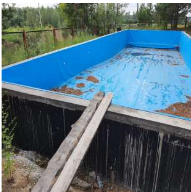
ремонт конструкции чаши плавательного бассейна
